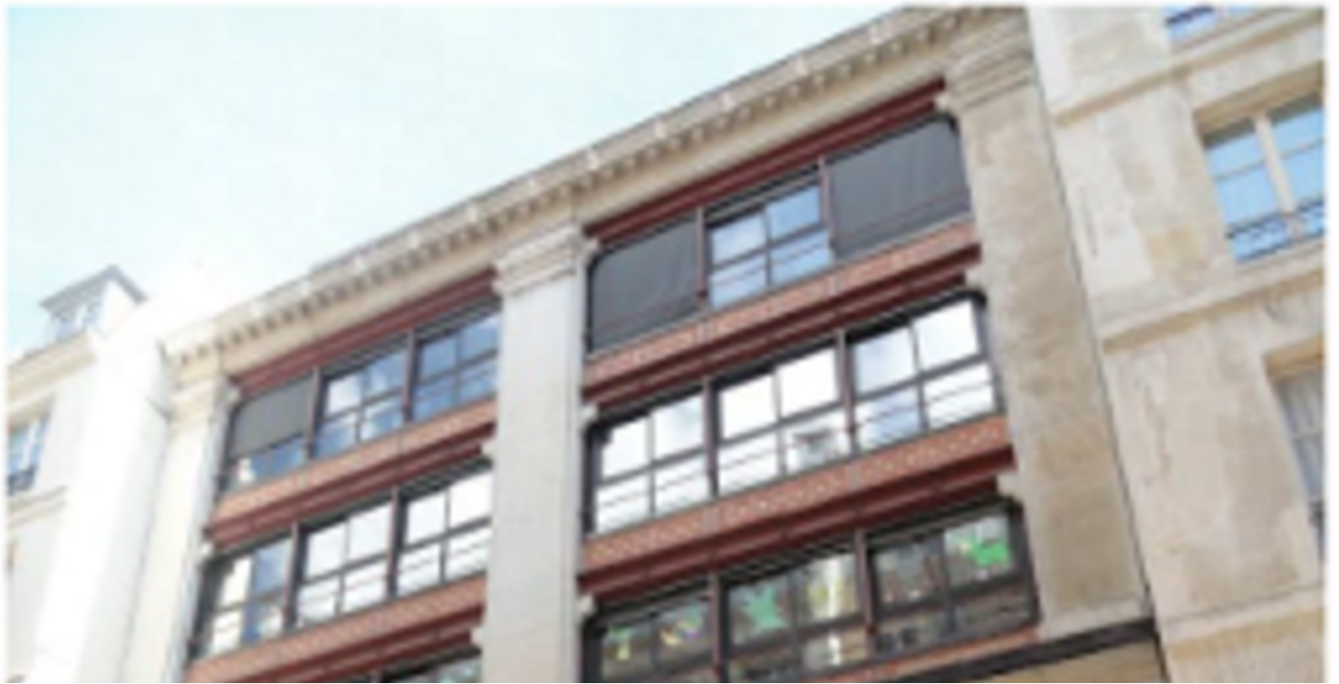
Mission de rénovation de la crèche Saint Roch avec intégration de matériaux biosourcés et matériaux de réemploi
